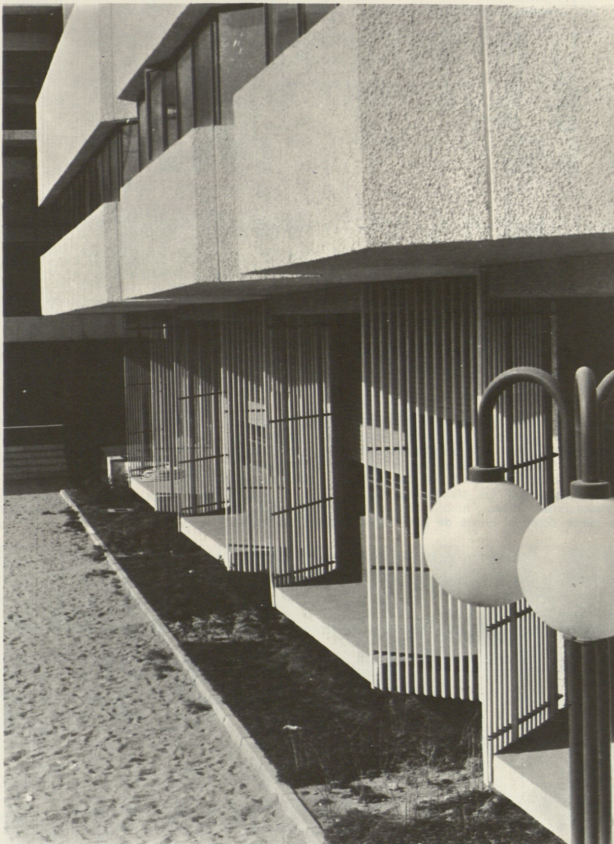
Vistas de las aulas desde el patio principal del Colegio "Juan de la Cierva".
